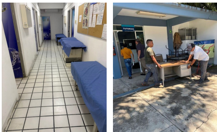
Foto 79. Área de Propedéutica posterior a la rehabilitación de piso y pintura, enero 2026. (f.izq)
