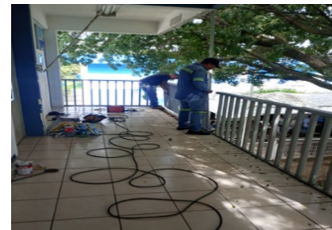
Foto 87. Recolocación del barandal exterior del departamento de Salud Pública posterior al retiro de la Tablaroca, junio 2025.
