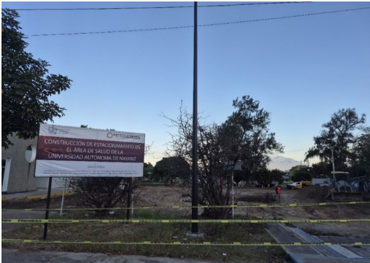
Foto 103. Inicio de la remodelación del estacionamiento del área de la salud, enero 2026.
