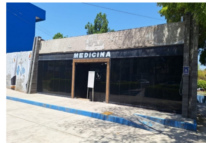
Foto 88. Fachada del Auditorio previa a la restauración, abril 2025.
