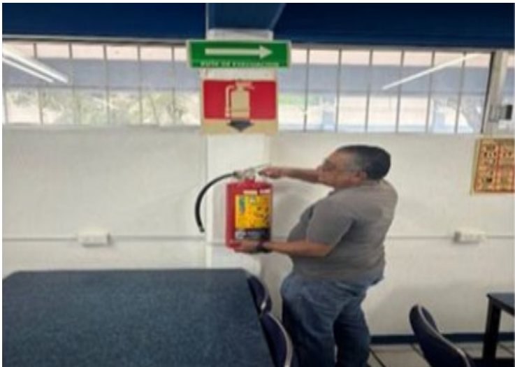
Foto 97. Colocación de señalética de seguridad así como extintores en diversas áreas, agosto 2025.
