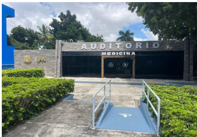
Foto 89. Restauración de la fachada del Auditorio que incluyó el reemplazo de azulejos, la rehabilitación de letras, la pintura de la rampa de acceso para personas con discapacidad y la restauración del escudo institucional, enero 2026.
